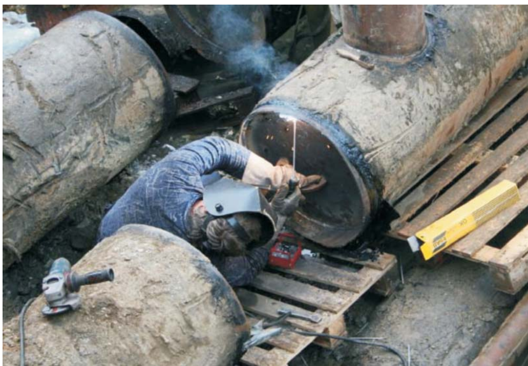
▲ Jednou z plnenia úloh celopodnikovej odstávky bolo aj zváranie potrubia cirkulačnej vody. Viac na 3. strane
