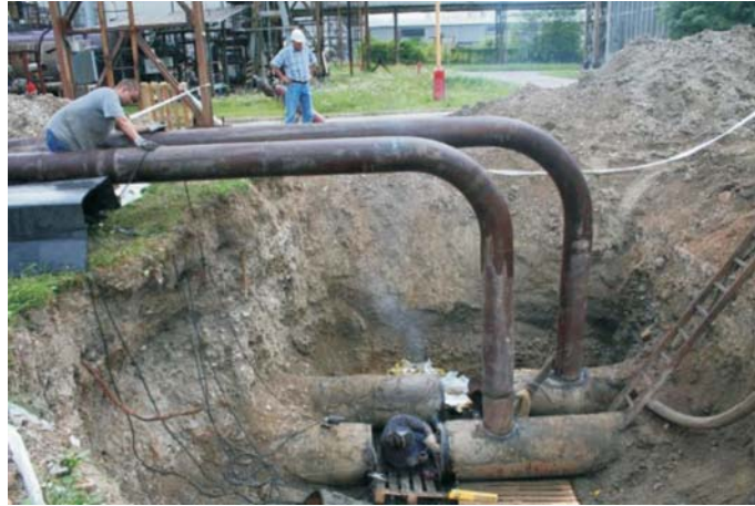
▲ Oprava potrubia cirkulačnej vody. Foto: P. Hudec
