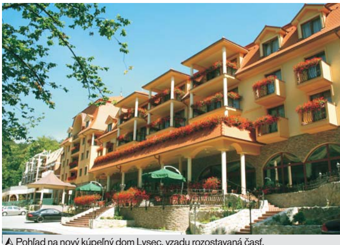
▲ Pohľad na nový kúpeľný dom Lysec, vzadu rozostavaná časť.
