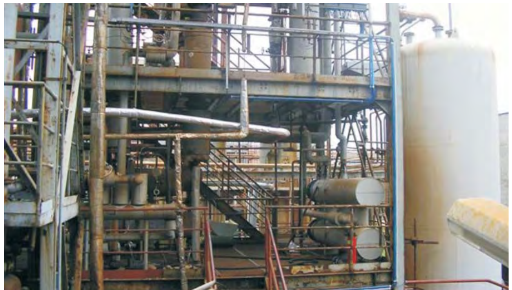
▲ Pohľad na stripovaciu kolónu odpadových vôd vo výrobní EDC/VC
