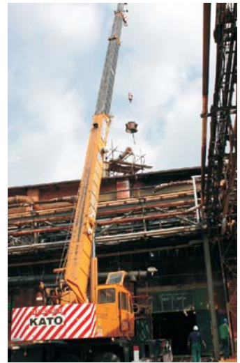
▲ Realizácia výmeny koncového stupňa na technologickom zariadení výroby chlomanu sodného.
