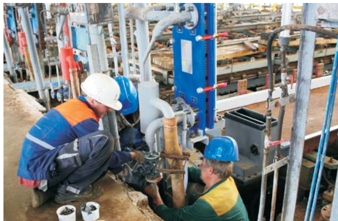
▲ Generálna oprava elektrolyzéra č.40
