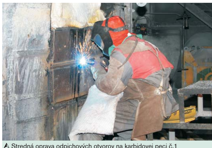
▲ Stredná oprava odpichových otvorov na karbidovej peci č.1
